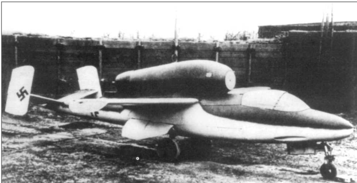
Хейнкель He 162A-1, выпущенный фирмой Юнкерс, вооруженный пушками МК 108. Серийные самолеты имели усиленную конструкцию крыла и отогнутые вниз законцовки («Уши Липпиша»).
